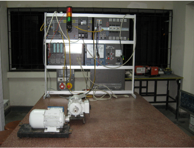
Figura 17.5: Módulo moderno de Control de Máquinas Eléctricas
