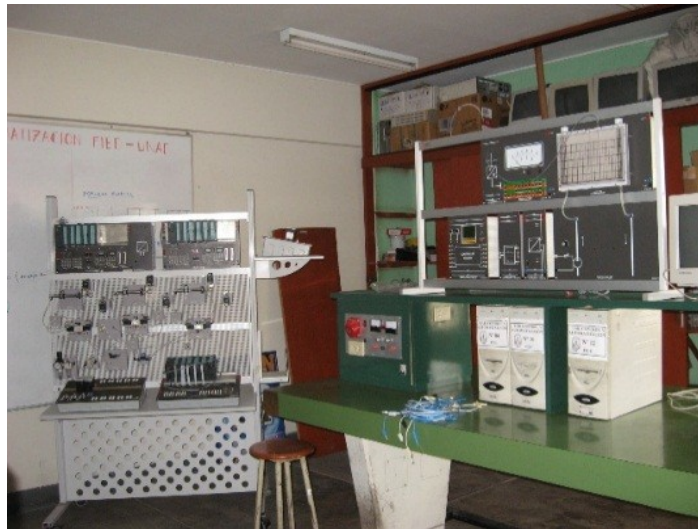
Figura 17.8: Módulos de Control y Automatización
